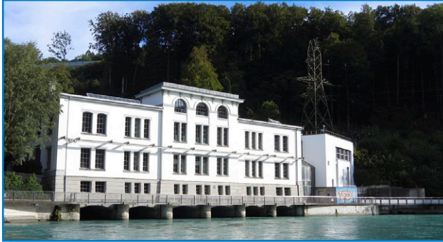
Felsenau vesivoimalaitos Bernissä.
